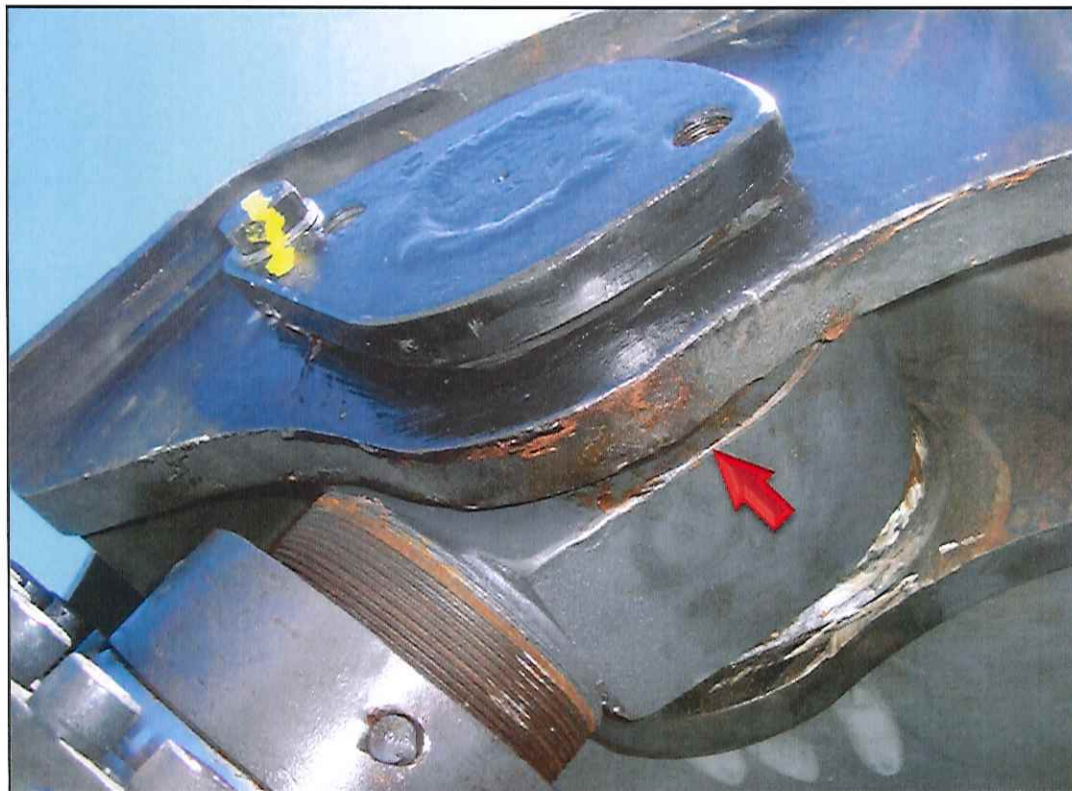
Figura 4. Detalhe do item de check-list #52; pequena folga entre o pino de junção do cilindro de elevação lado esquerdo e o mancal da lança.
