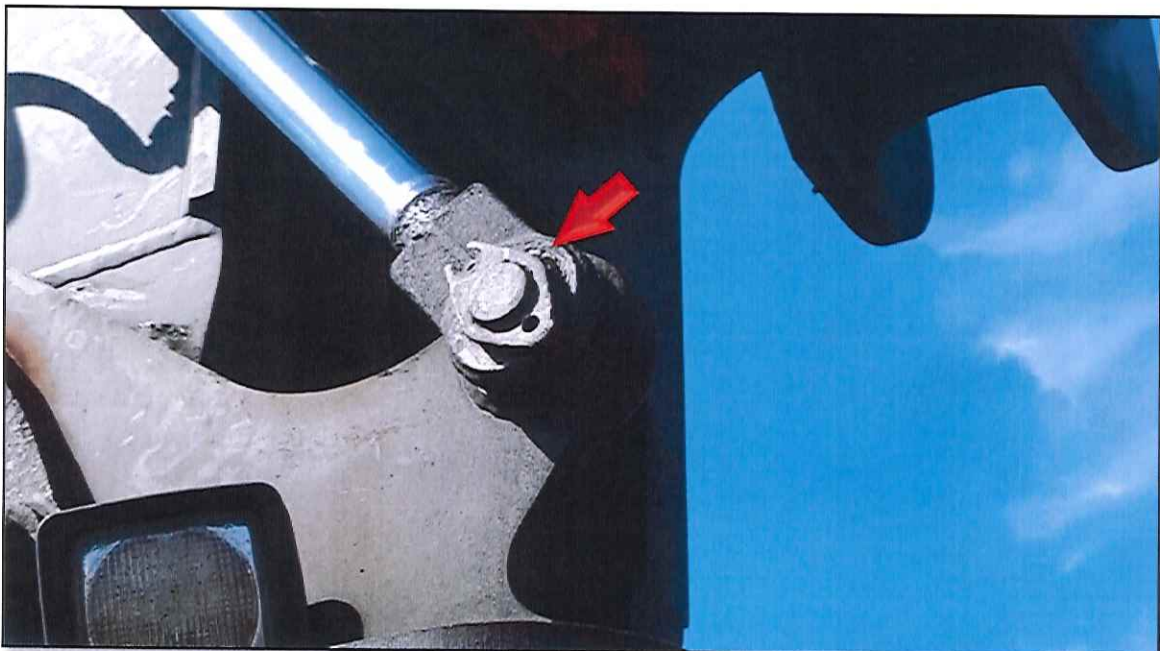
Figura 4. Detalhe do item de check-list #54; pinos de junção inferiores dos cilindros de tilt estão com seus olhais soldados.
