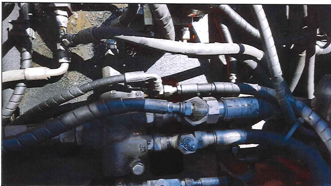
Figura 6. Detalhe do item de check-list #68; vestígios de vazamento de óleo hidráulico presentes na válvula prioritária.
