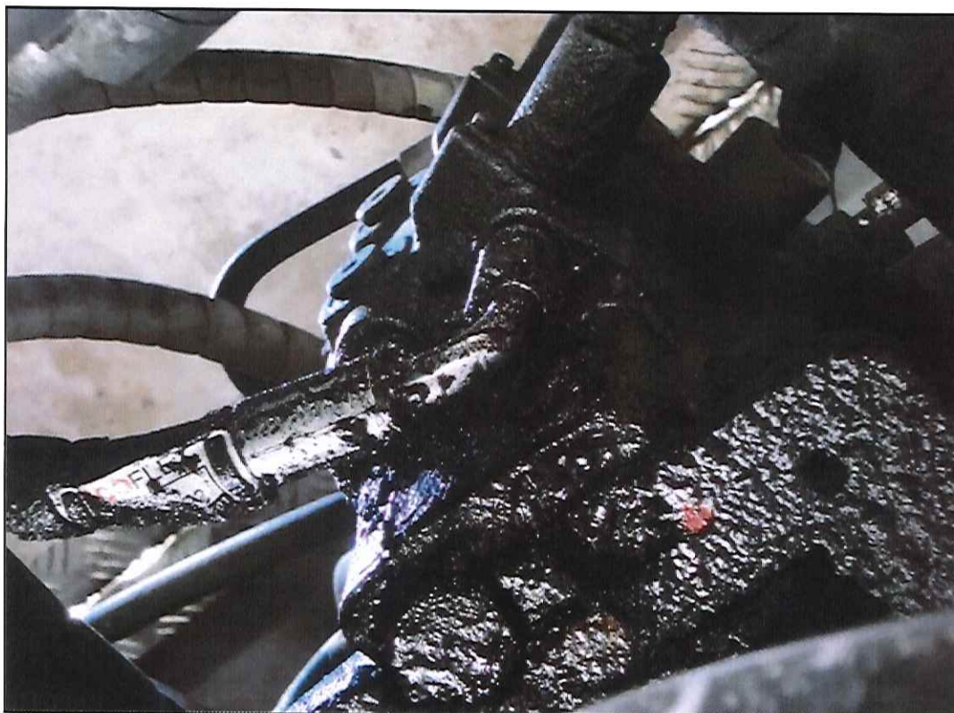
Figura 4. Detalhe do item de check-list #66; vazamento de óleo hidráulico na mangueira de pilotagem do bloco da bomba principal direita.
