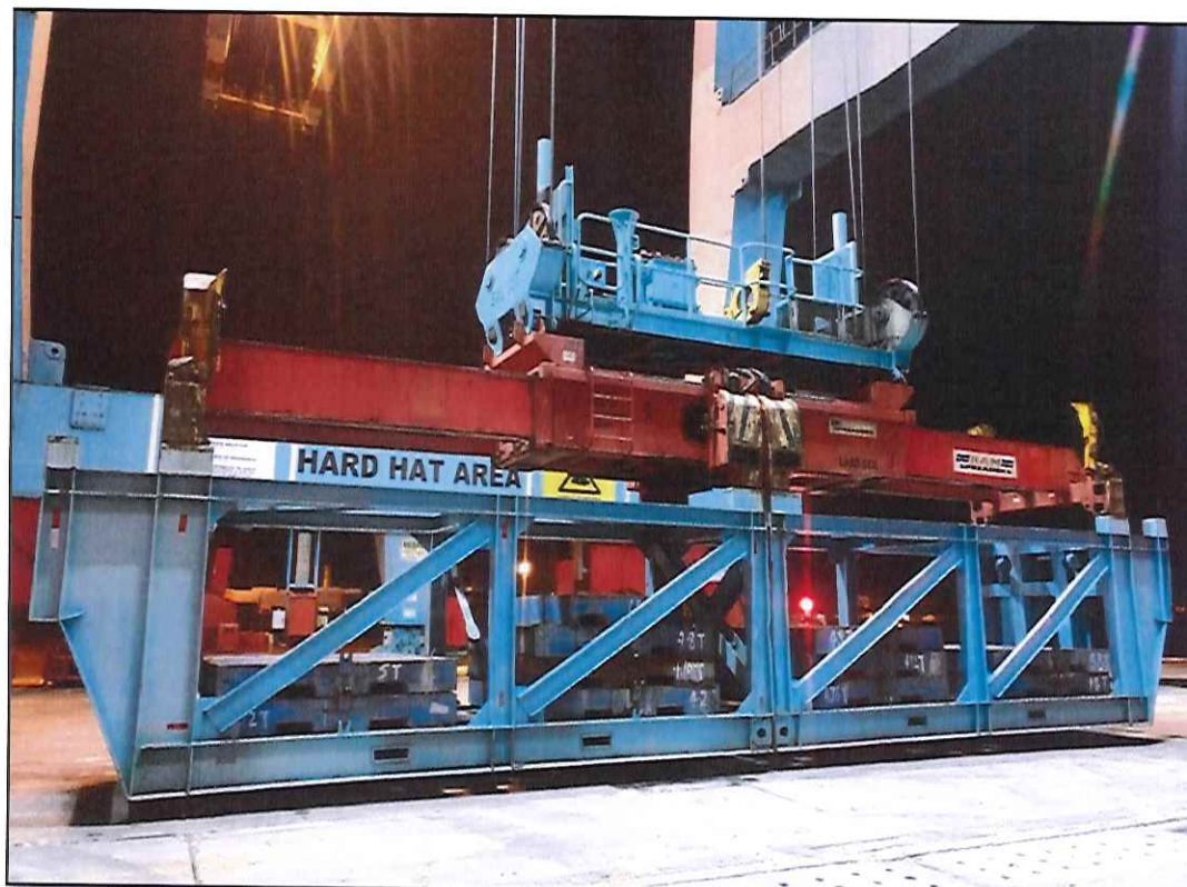
Figura 9. Teste de carga – Twin Lift.
