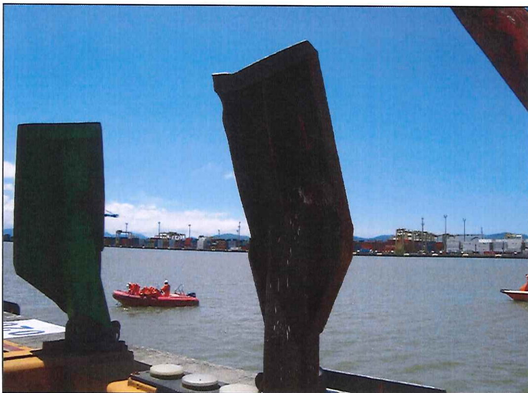
Figura 4. Detalhe do item de check-list #13; flipper preto se encontra avariado.
