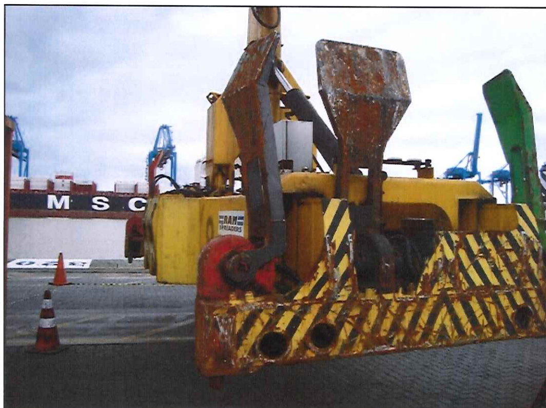
Figura 5. Detalhe do item de check-list #15; flipper do atuador hidráulico vermelho precisa ser pintado.
