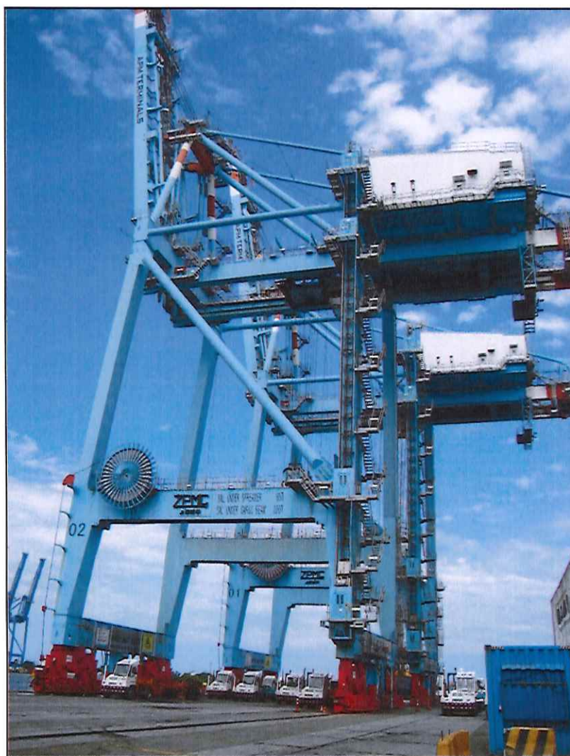
Figura 1. Guindaste de cais (portainer), STS-02.
