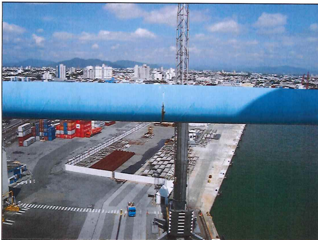
Figura 10. Detalhe do item de check-list #47; corrosão na viga de ligação lateral da estrutura do pórtico, lado esquerdo.
