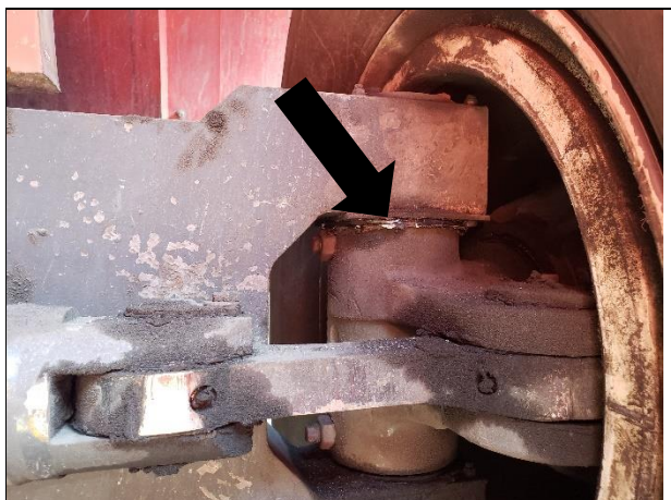
# item 42 – calço deslizante com desgaste
