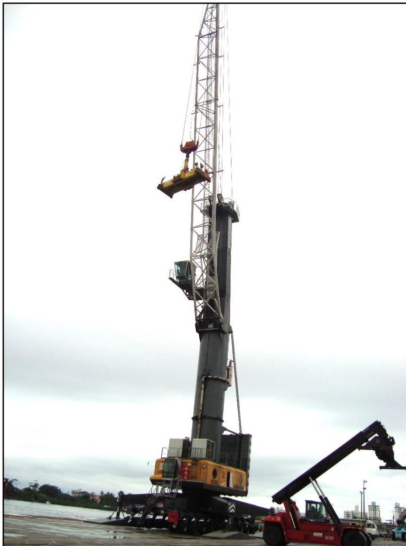
Figura 1. Guindaste de cais (Mobile Harbor Crane), MHC-02.
