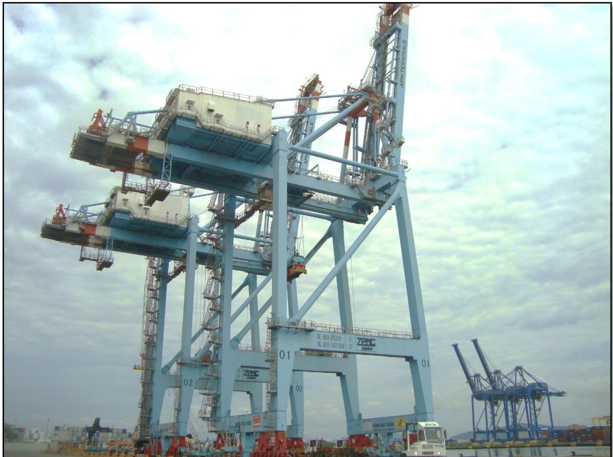
Figura 1. Guindaste de cais (portainer), STS-01.
