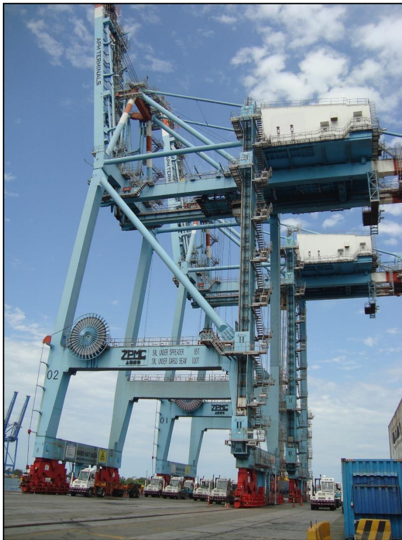
Figura 1. Guindaste de cais (portainer), STS-02.
